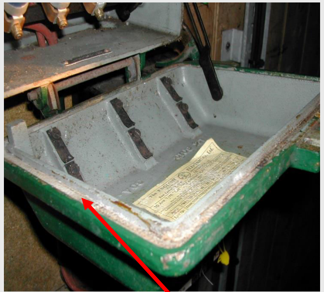
Switchgear Door Seal
